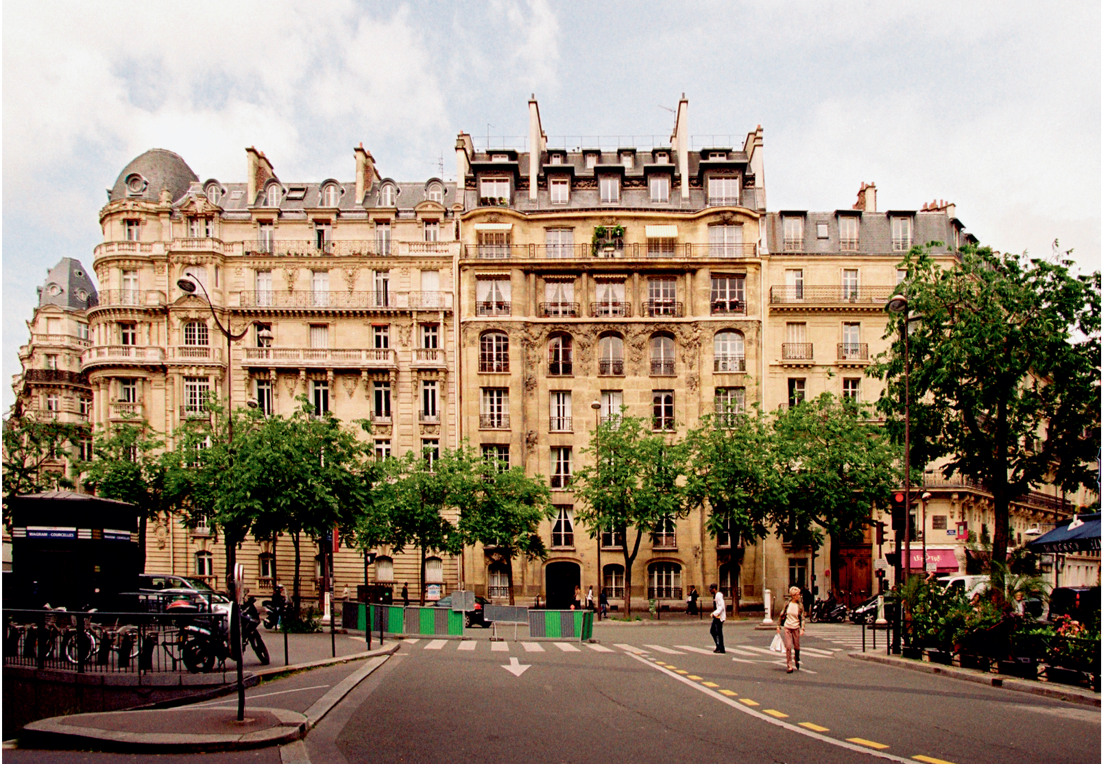
Gevel als onderdeel van het bouwblok aan de Avenue de Wagram Façade as component of the building block on the Avenue de Wagram
