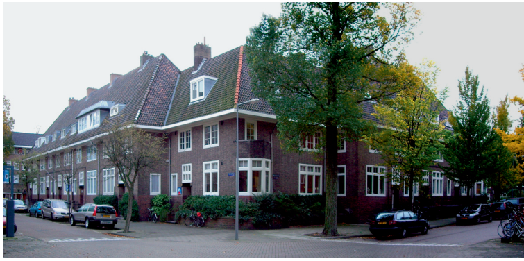
Afscheiding tussen Veronesestraat en de binnenhof Partition between Veronesestraat and the courtyard
